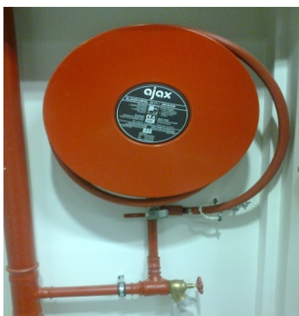
Figuur 20: Haspel met axiale voeding MET muurhydrant of DSP-mondstuk \text{Ø} 45 mm
